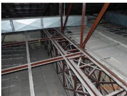
Estructura de soporte del Puente de Luces, sobre sala principal.
