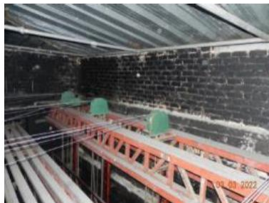
Zona de tramoya, parilla y poleas de tiro (color verde) del sistema contrapesado
